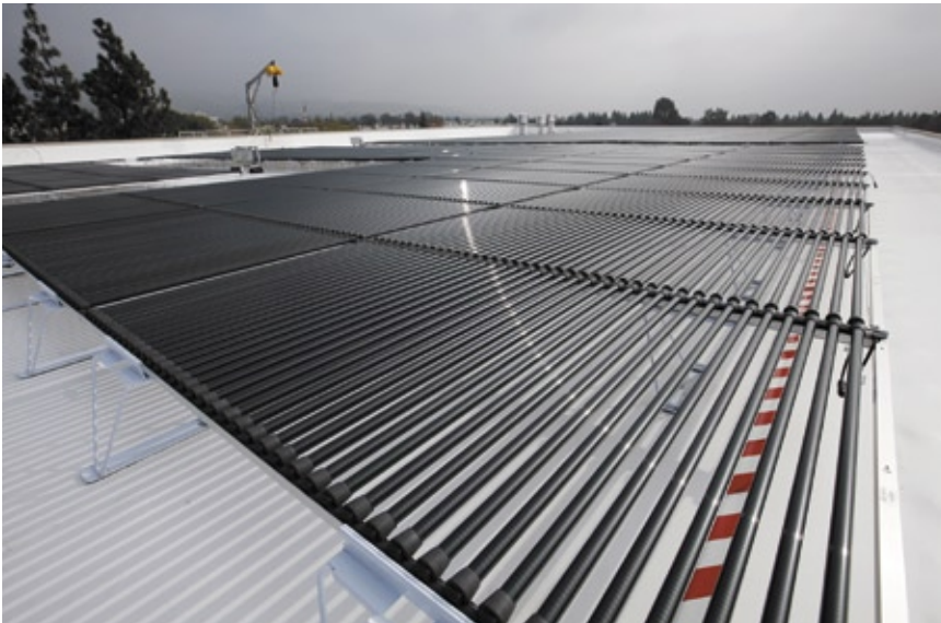
Auf dem weißen Dach von Solyndra erinnern die photovoltaischen Systeme an solarthermische Vakuumröhrenkollektoren
